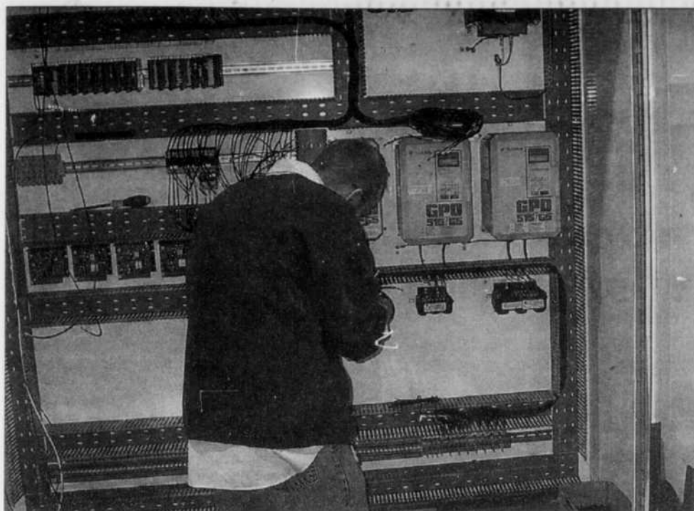
Assemblage d'un panneau de contrôle.
