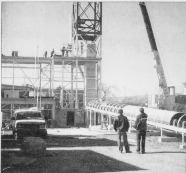
Installation de la structure d'acier du poste de transbordement de grain.
