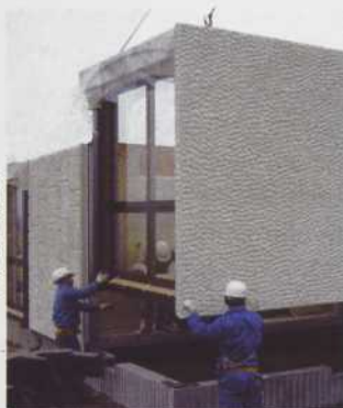
Ligne de montage de modules à ossature d'acier (Sekisui Heim-Japon).
