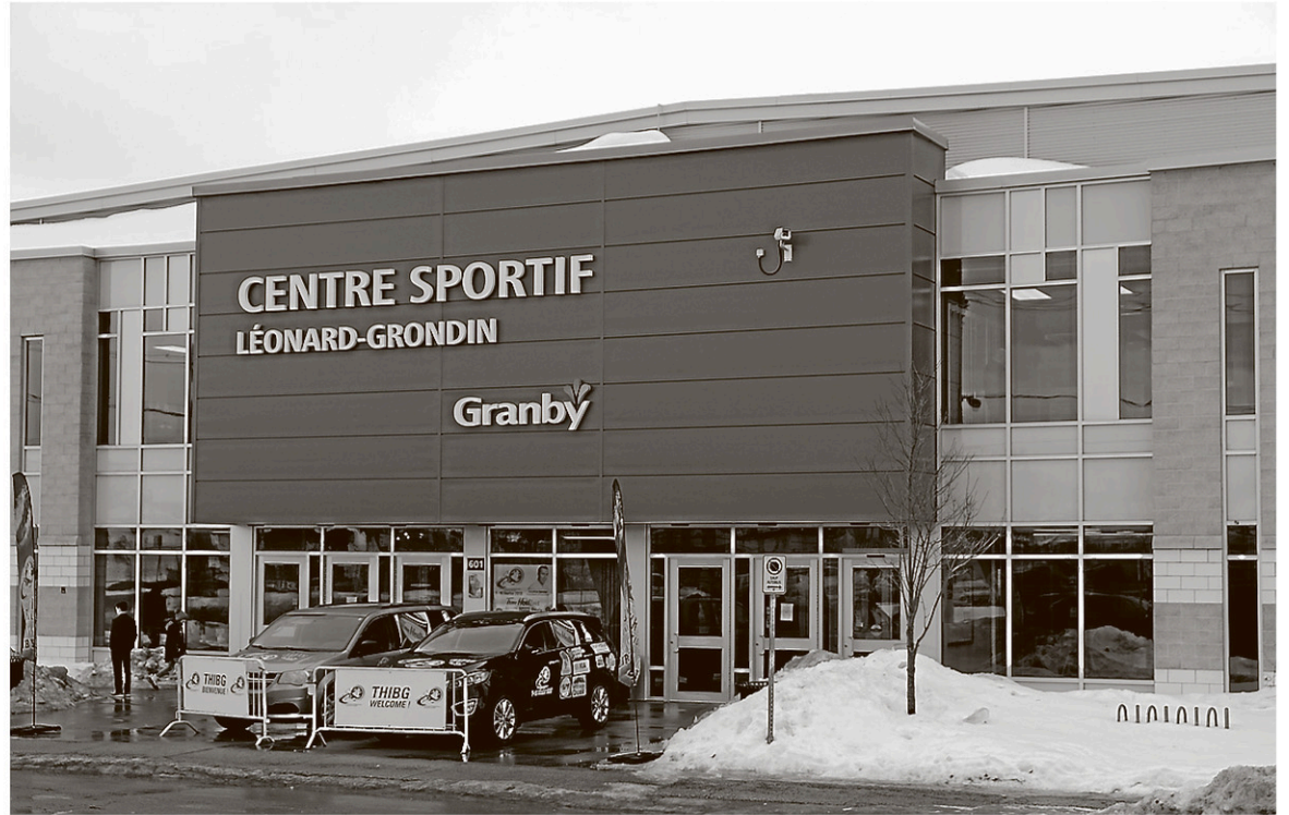
Le système de chauffage au glycol du centre sportif Léonard-Grondin connaît des ratés. — PHOTO ALAIN DION
