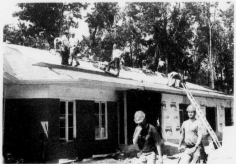
Les travailleurs de la FTQ Construction avaient construit bénévolement la nouvelle aile de la Maison Victor-Gadbois. (Photo d'archives)
