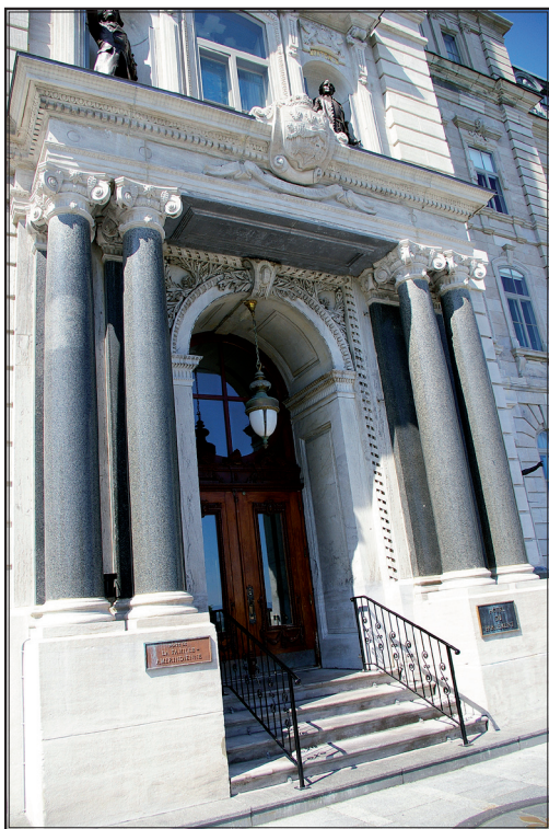
Portail de l'Entrée d'Honneur de l'Hôtel du Parlement : colonnes en granite de Quincy; chapiteaux, voûte, tympan, ruban spiralé et murs en calcaire de Terrebonne; entablement et cartouche des armoiries du Québec en calcaire de Saint-Marc-des-Carrières.
