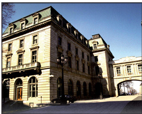
Édifice Pamphile-Le May : embasement en granit Gris-Bleu de Rivière-à-Pierre, et parement des murs en calcaire de Saint-Marc-des-Carières.
