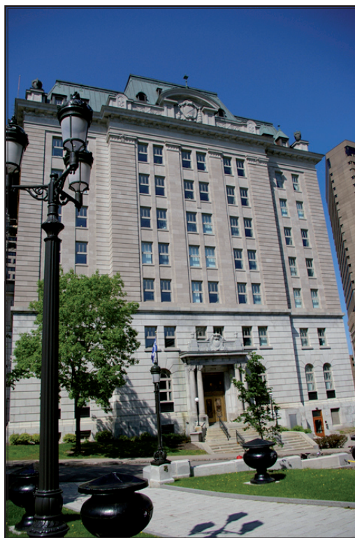
Édifice Jean-Antoine-Panet : le rez-de-chaussée et le premier étage sont en granite Gris Scotstown; les colonnes, les chapiteaux, l'entablement, le parapet, le cartouche et les urnes, en granite Gris Saint-Sébastien; et les cinq étages supérieurs, en calcaire de Saint-Marc-des-Carrières.
