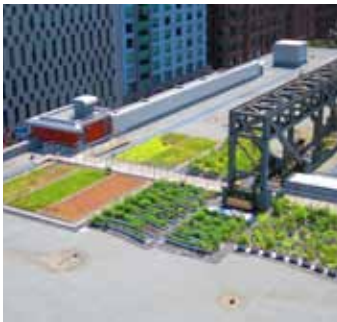
Culti-vert on the roof of the Palais des congrès de Montréal.
