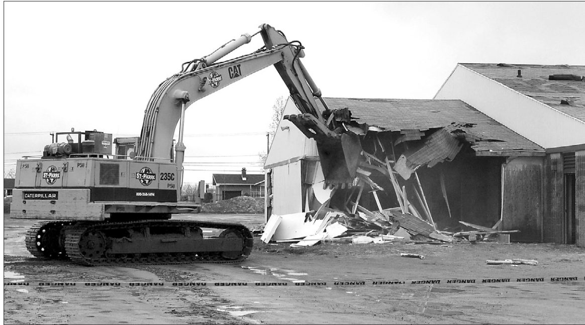
La pelle mécanique s'est affairée à démolir la première écurie, hier. Les activités de démolition se poursuivent d'ailleurs aujourd'hui.
