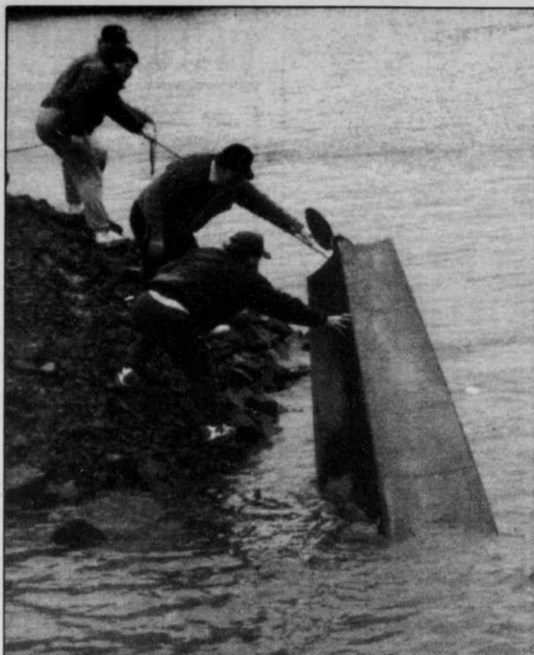
Des secouristes installent un pont flottant sur les lieux de la tragédie.
