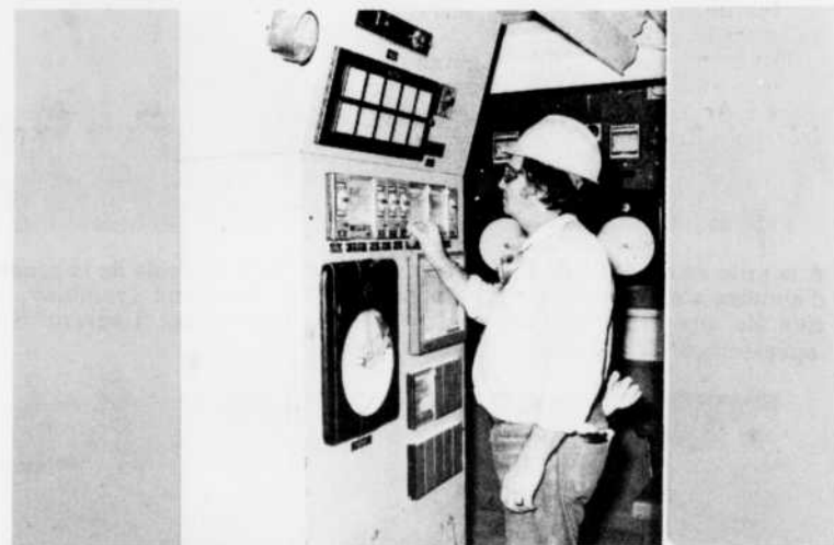
C'EST ICI QU'ON DONNE les préventions de la météo des fours rotatifs. Le récepteur indique la température des fours rotatifs transmise par les antennes, le transmetteur et un appareil spécial qui mesure le degré de chaleur. Sur la photo, M. Roland Côté, opérateur d'alimentation des fours à l'usine de calcination no 2, lit les cadrans du récepteur. Aussi, à droite, UNE RADIO FM pour plus de chaleur. Le système de télémétrie indique la température des fours rotatifs.
