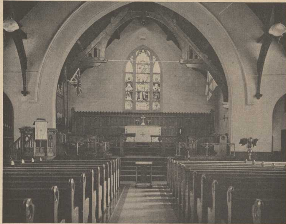
Le théâtre des Compagnons, tel qu'il apparaissait avant sa rénovation...
