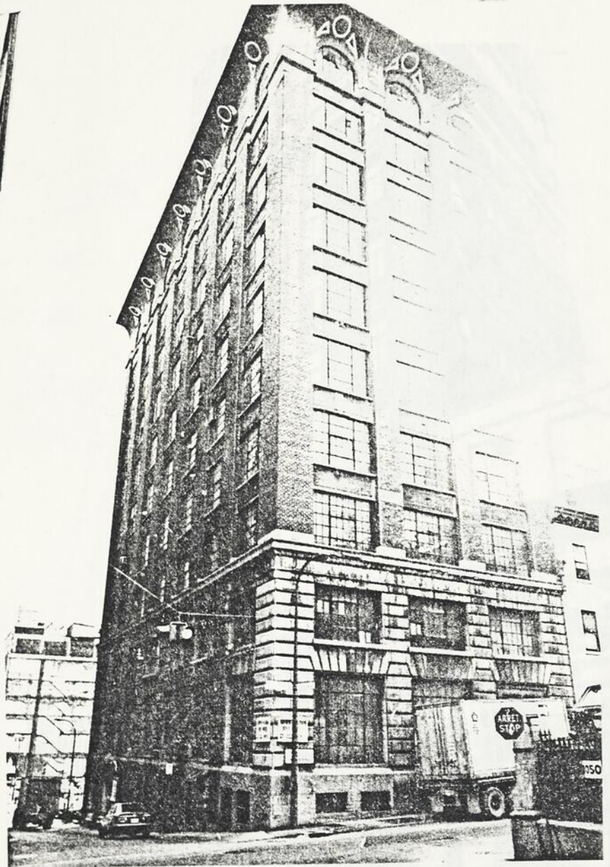
Fig. 262 Edifice Unity, 454 de La Gauchetière O.
