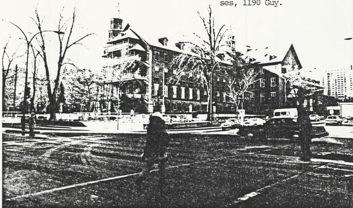
Fig. 176 Maison-mère et hôpital général des soeurs Grises, 1190 Guy.
