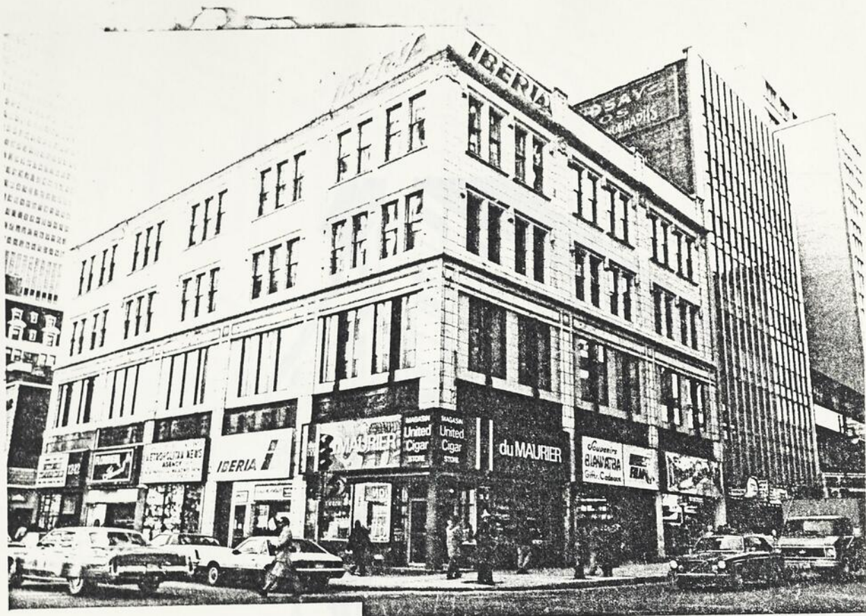
Fig. 256 Edifice 1100-08 Sainte-Catherine O.
