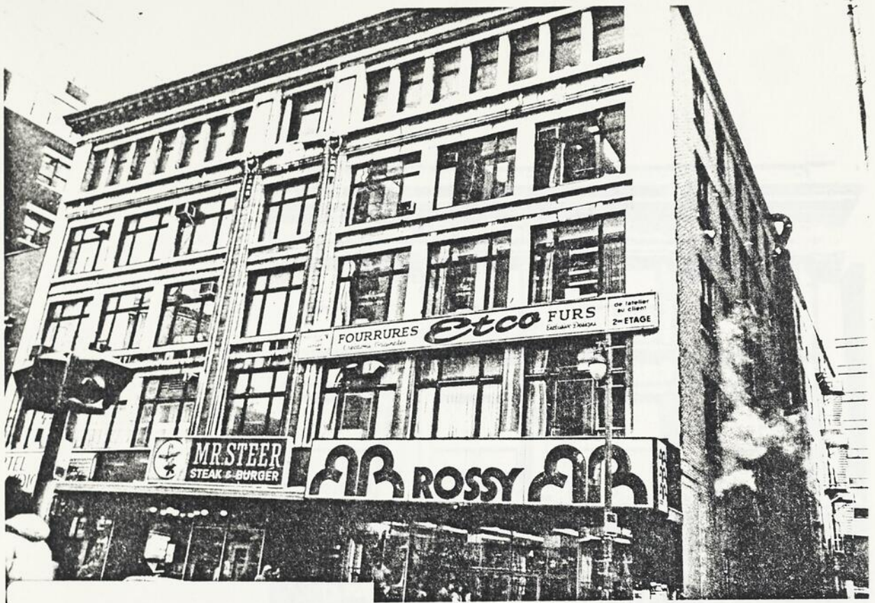
Fig. 267 Edifice 482-8 Sainte-Catherine O.
