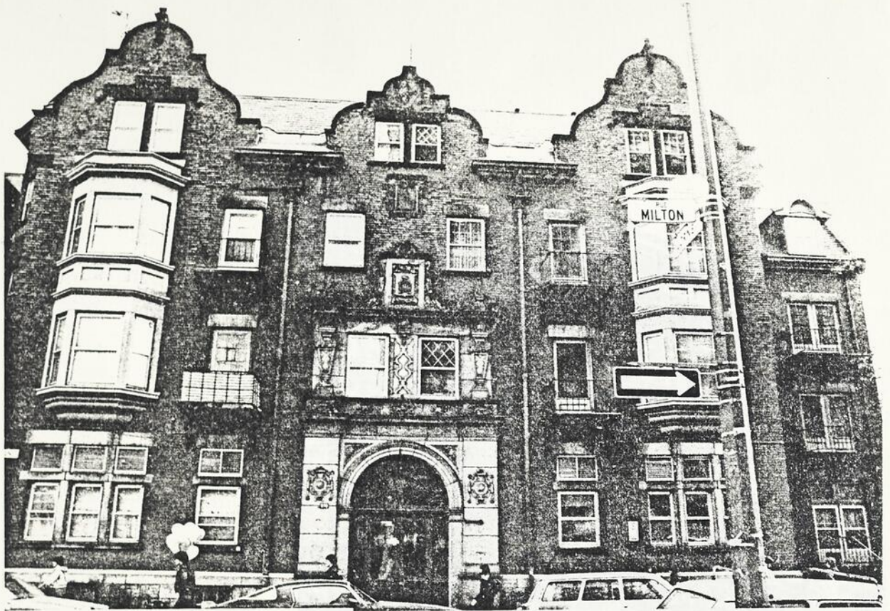
Fig. 104 Appartement Marlborough, 570 Milton.
