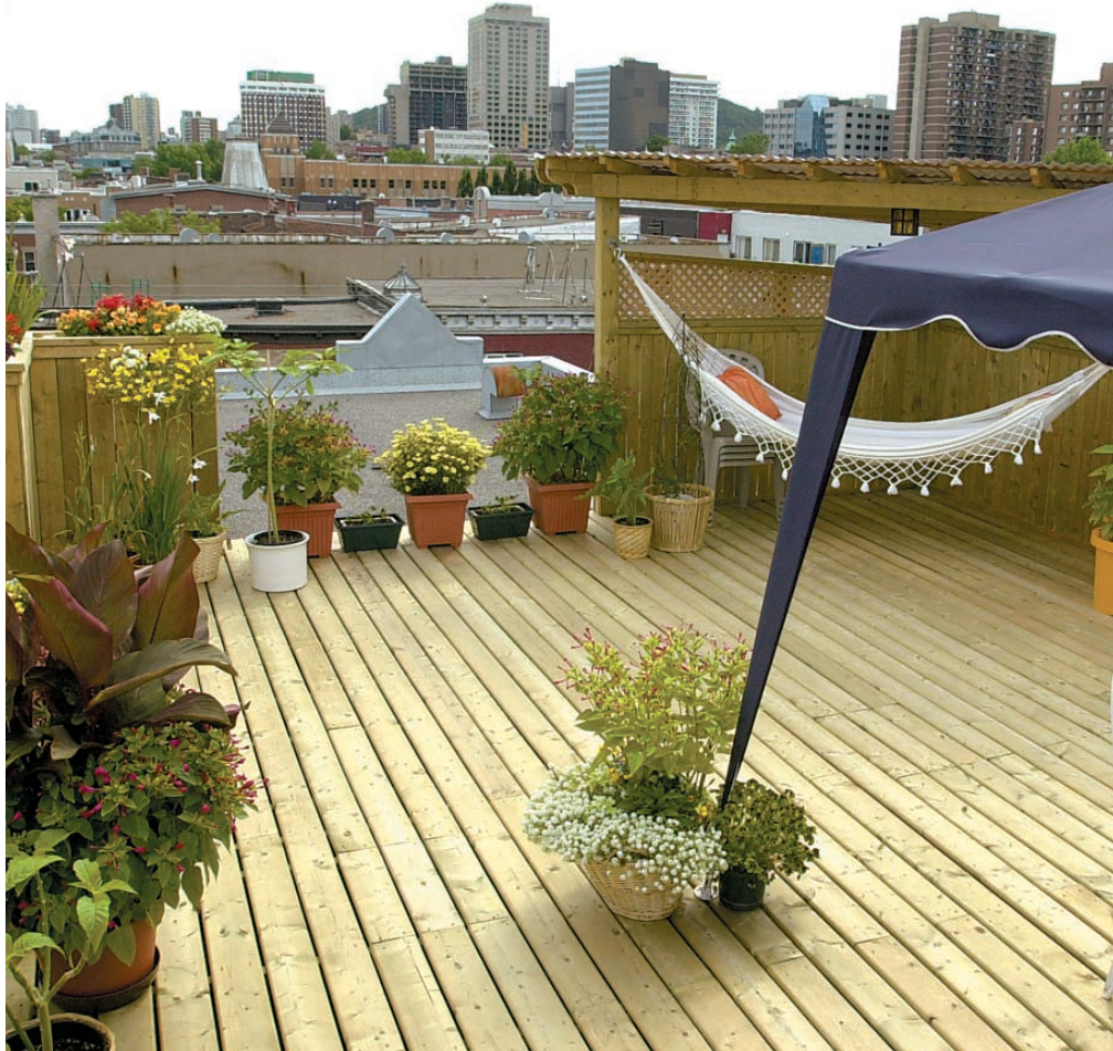
La torréfaction sera bientôt une solution de recharge au traitement chimique pour préserver le bois destiné à la construction des terrasses.
