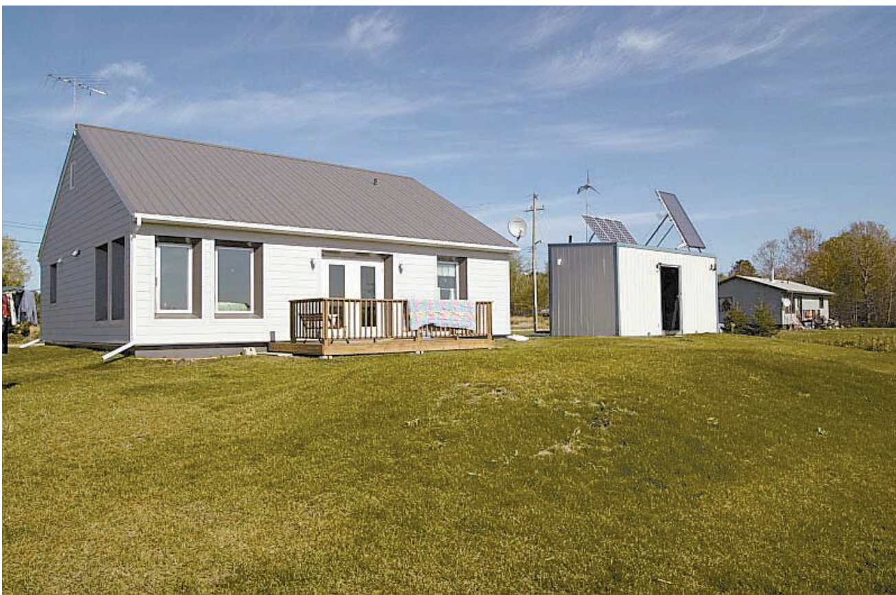
La maison saine de Toronto (ci-haut), conçue par la SCHL, est dotée de panneaux photovoltaïques (PV) et thermiques (pour chauffer l'air et l'eau). Ces panneaux PV assurent une bonne partie de l'alimentation en électricité. Quant à la maison saine d'Eagle Lake, elle n'est pas alimentée à l'hydroélectricité, mais à l'énergie solaire.
