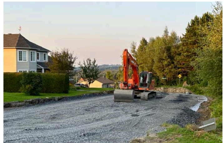
Rue Industrielle-Nadeau - Fin de la Phase 1: Travaux de réaménagement en cours
