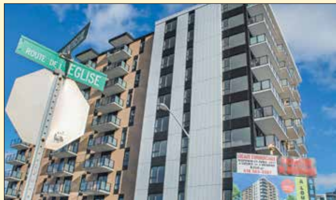
Sur la rue de l'Église, plus de la moitié des unités du projet Condos locatifs Campari ont trouvé preneurs. Les locaux commerciaux sont disponibles depuis le début du mois d'avril.
