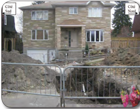
Vue de la tranchée en face de la résidence (CSST)
