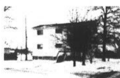
1908. COTTAGE aux possibilités nombreuses, 5 c.c., vue sur le canal, près terrain de jeux, dépanneur. Marcelle B. Ratté
