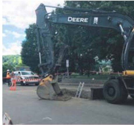
C'est ce mardi 20 juin dernier qu'une équipe des Travaux publics de la Ville de Saint-Sauveur a eu toute une surprise en déterrando des ossements humains lors d'une opération d'excavation d'une partie de la chaussée sur la rue de l'Église, vis-à-vis de la boulangerie Pagé.
