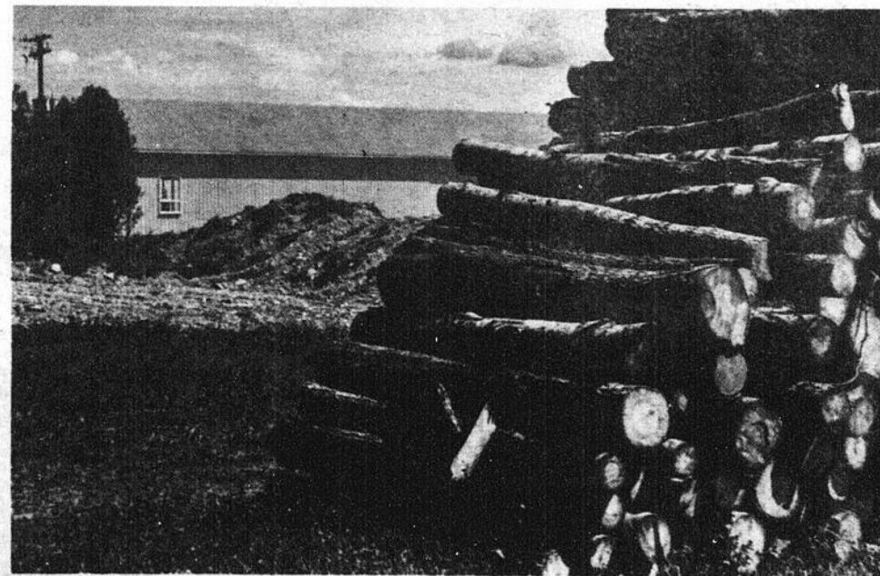
Déjà les billes de tremble et de peuplier commencent à s'empiler à proximité de l'usine en construction. On prévoit traiter plus de cinq millions de pieds de tremble par année.
