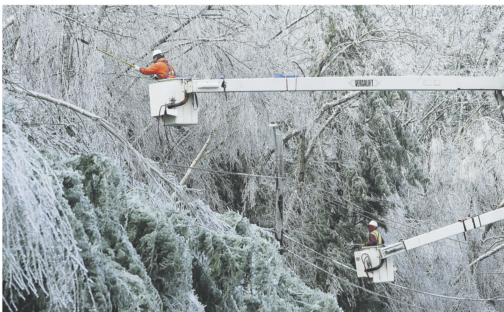
Hydro-Québec a envoyé 75 employés dans le nord-est américain pour aider à réparer les lignes électriques endommagées par le verglas.
