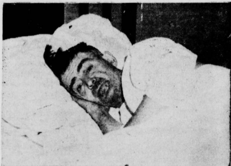
M. Ferdinand LAMOTHE, 49 ans, 105, Place Jacques-Cartier, qui eut la colonne vertébrale fracturée, hier après-midi, lorsqu'un épais mur de ciment destiné à la construction d'un garage, en arrière du no 3436, rue St-Denis, s'écroula soudain sur lui et trois autres compagnons de travail. Ceux-ci furent plus heureux et s'en tirèrent à bon compte. M. Lamothe est hospitalisé à St-Luc.
