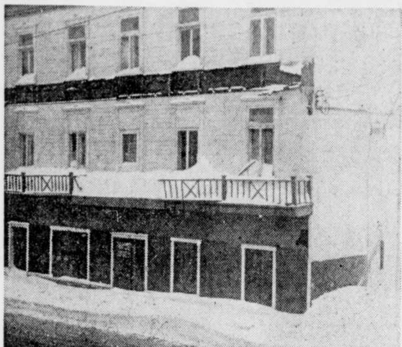
A démolir Voici un vieil édifice devenu très dangereux, situé sur la rue Commerciale, tout près de la Traverse de Lévis. Les autorités municipales l'ont condamné au pic des démolisseurs, l'automne dernier, mais la démolition retarde toujours. L'immeuble est abandonné depuis de nombreuses années. Jadis, quand il était encore solide, c'était l'hôtel Guy.
