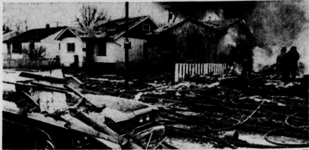
Un départ remarqué Une maison a été complètement rasée par une explosion qui a en outre endommagé ses six voisines, à Winnipeg, mardi. La police croit qu'il s'agit d'une explosion due au gaz naturel. Personne n'a été tué mais il y a eu plusieurs blessés.
