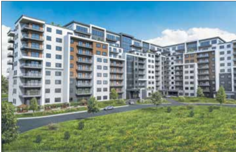
Les travaux de construction du complexe pour retraités viennent de débuter sur la rue de l'Interlude. Le projet de 65 M$ comptera au total, 300 unités de type 2½, 3½, 4½ et 5½ disponibles pour les aînés de la région à l'automne 2018.
