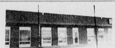
Immeuble commercial 40' x 80' rue Rivard, 2ième est, centre industriel
