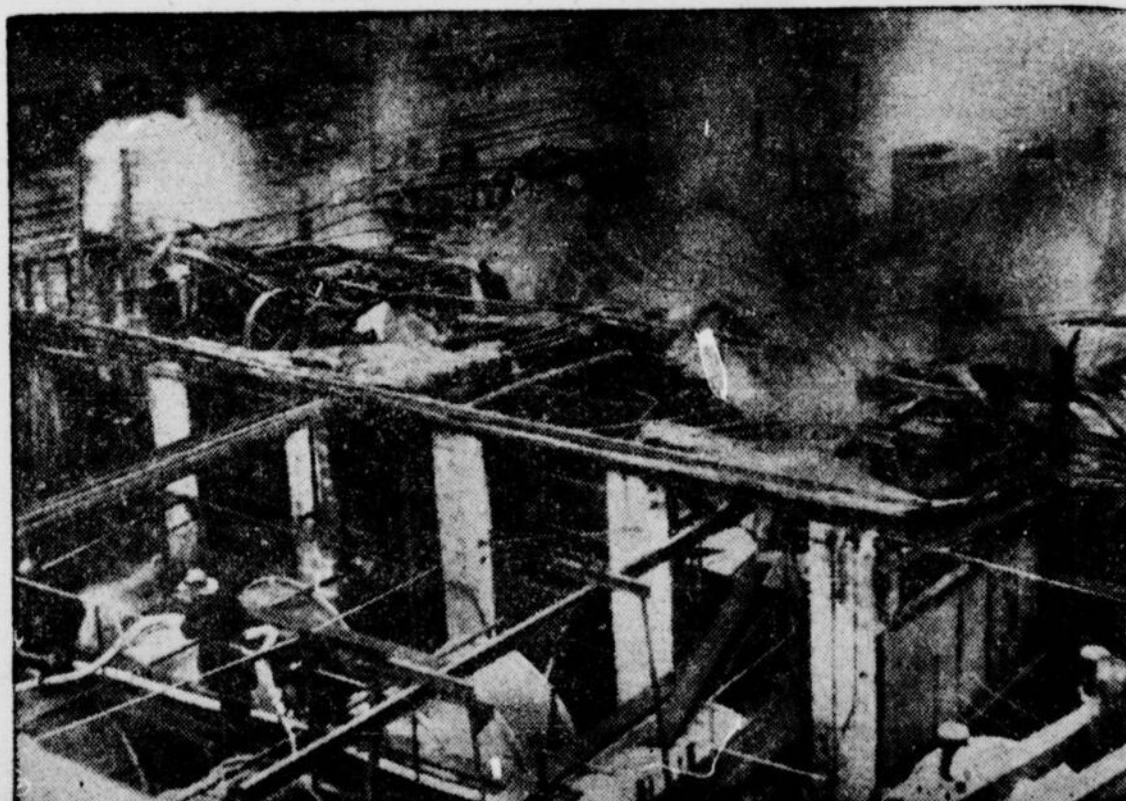
Des matières explosives ont alimenté un incendie qui a ravagé les usines de la Quaker Chemical Products Corporation (ci-dessus), à Spring Mill, près de Conshohocken, en Pennsylvanie, causant
