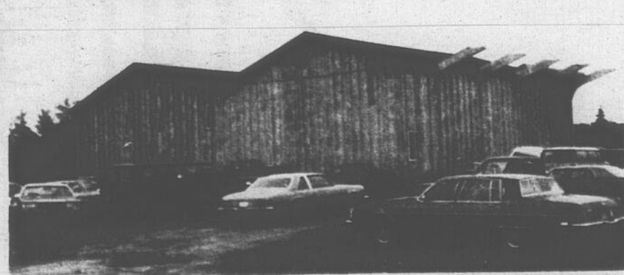
(photo l'Echo de Frontenac)
