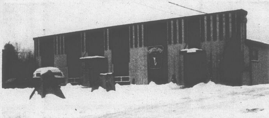
(photo l'Echo de Frontenac)
