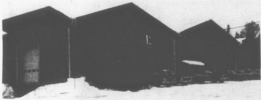
(photo l'Echo de Frontenac)
