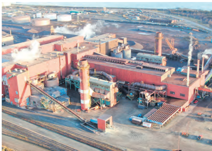
Usine de bouletage de Port-Cartier. Photo: courtoisie Arcelor Mittal
