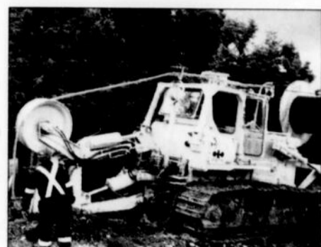
Enfouissement de câbles à fibres optiques, projet Amos/Matagami.
