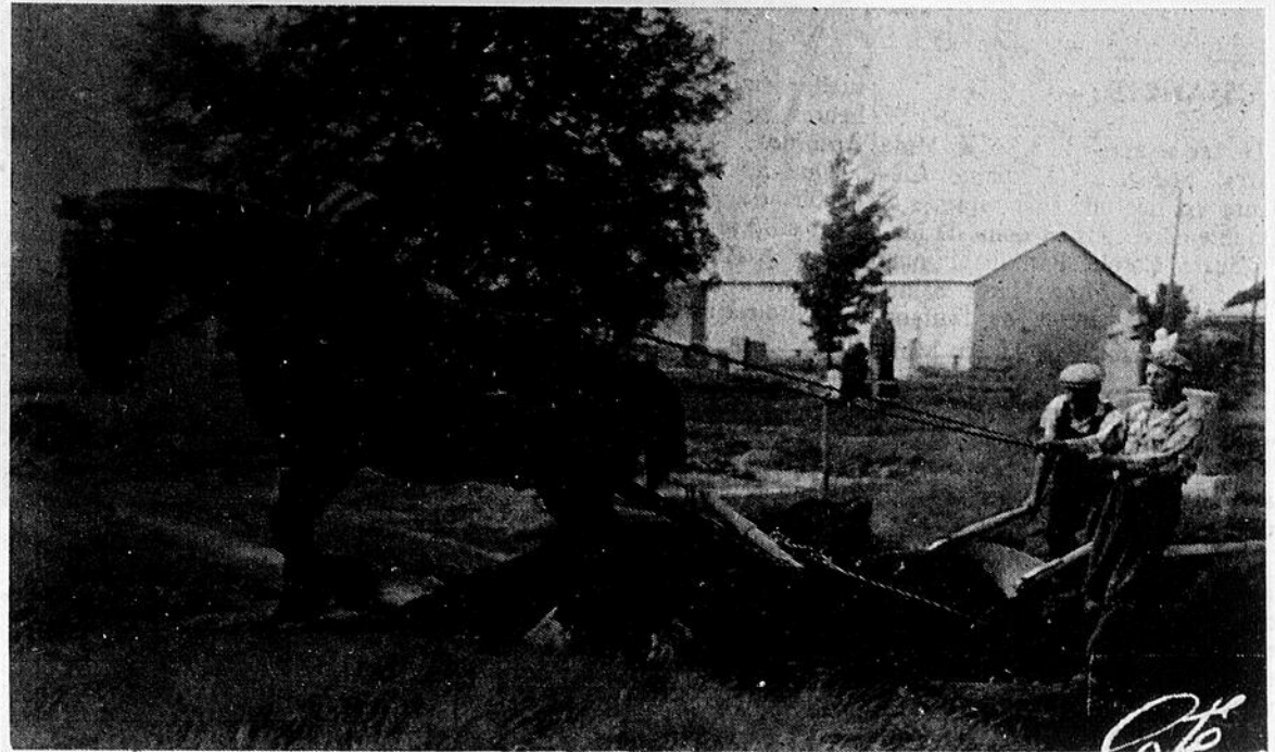
DES TRAVAUX d'amélioration ont lieu présentement, au cimetière de Louiseville. On voit ici M. Euclide Gélinas et un aide travaillant à ces améliorations.
