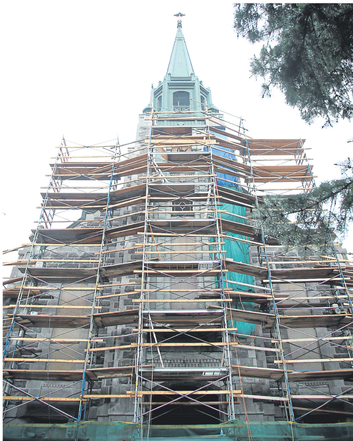
Les travaux de la façade de l'église Saint-Michel vont bon train et devraient être terminés à la fin du mois de septembre.
