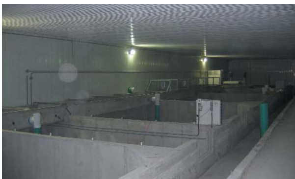
Ferme piscicole des Bobines inc., bassins en béton de 100 m 3 de type « Cornell » de forme carrée et à coins chanfreinés.
