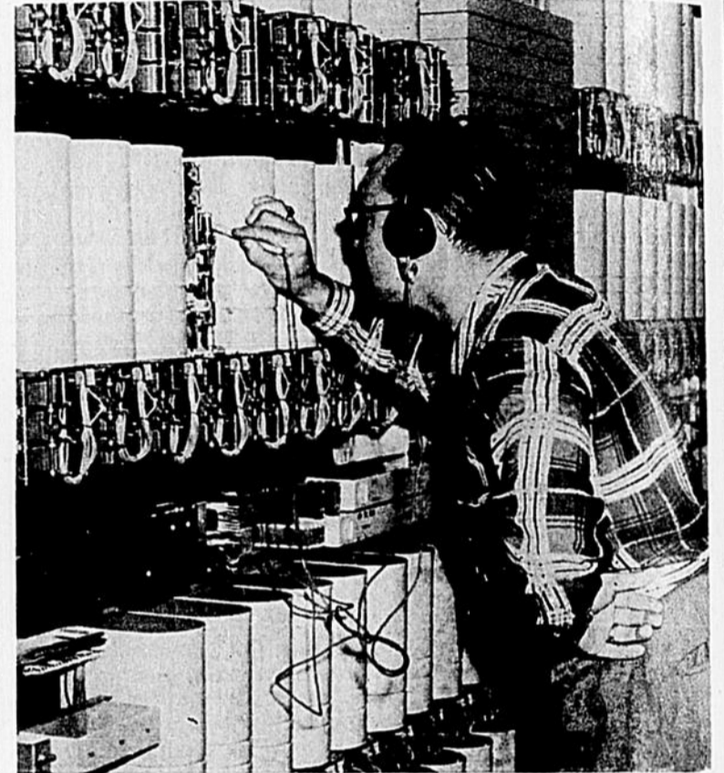
Marcel Forget, technicien de la compagnie Bell à Trois-Rivières, teste ici un chercheur de ligne au central automatique de Champlain. A compter de dimanche prochain à 3.01 du matin, ces commutateurs automatiques se mettront à cliqueter chaque fois qu'un usager du téléphone composera un numéro. Autant dire que du moment de la mise en service du nouveau central automatique, le silence sera définitivement chassé de ce central.
