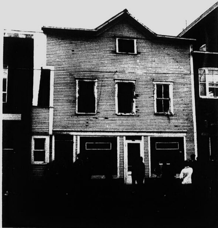
C'est dans l'appartement du 2ème étage, fenêtre de gauche où périrent MM. Cyrias Bolduc et Josaphat Aubé. Cette photo fut prise après que l'incendie eut été maîtrisé.
