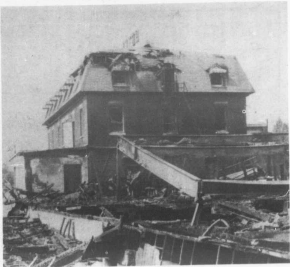
L'Hôtel Vannini ou ce qui en reste après l'incendie qui serait d'origine criminelle.
