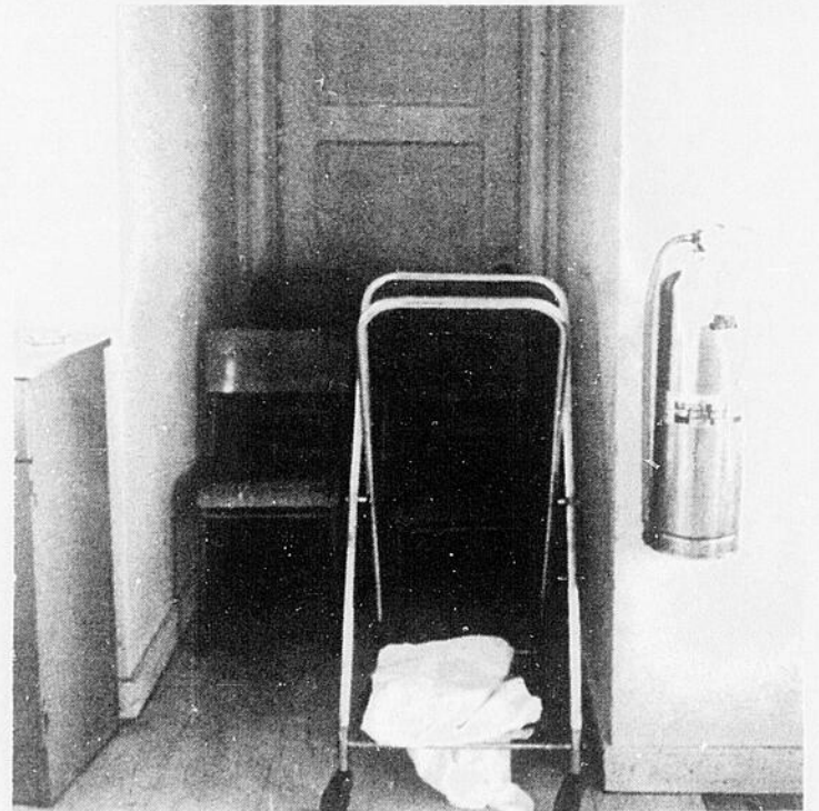
DES SORTIES DE SECOURS largement dégagées comme en témoignent cette photo.
