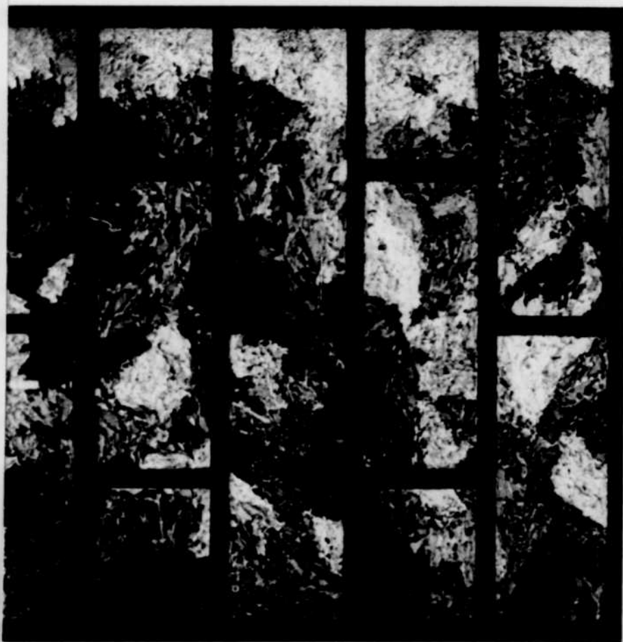
Deux détails de la verrière de l'Académie de Québec. Le verre découpé est fusionné au four et monté sur place ◀
