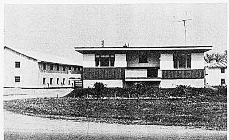
La Ferme Avicole Melançon a grandi un peu tous les ans depuis 6 ans. Et la maison ne fut pas la première réalisation. On voit ici une partie de l'ensemble. Chose digne de mention, le propriétaire a tout exécuté de ses mains sans jamais payer un sou de main-d'oeuvre. Il est confortable, les poules de même.
