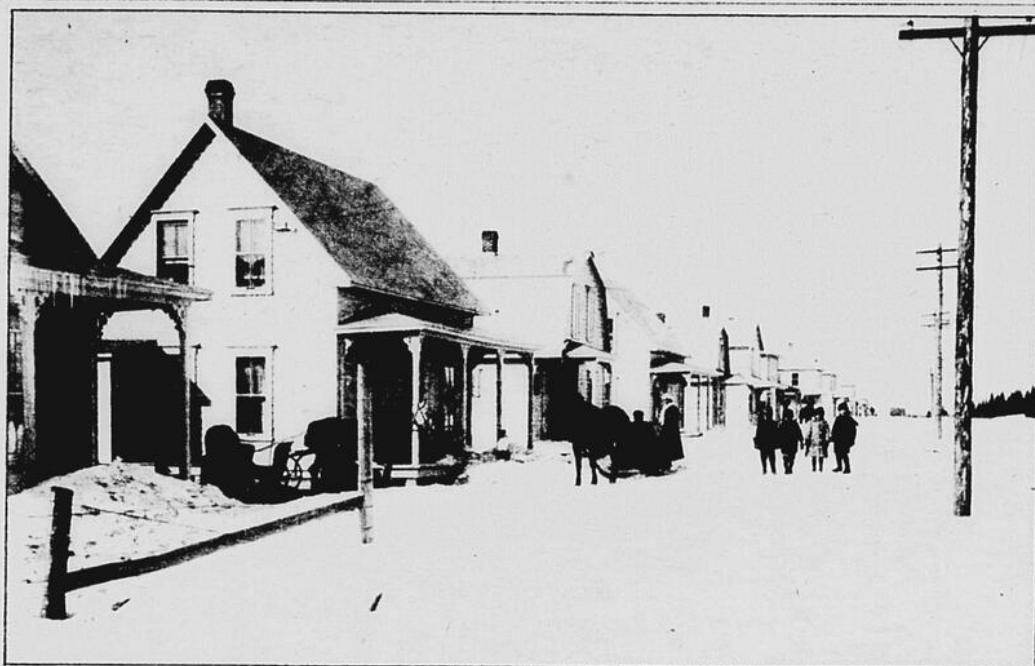
A gauche, le transport du bois dans un chantier (1909) et le moulin de Val-Jalbert (1907); ci-dessus, une rue de Kénogami en 1927.
