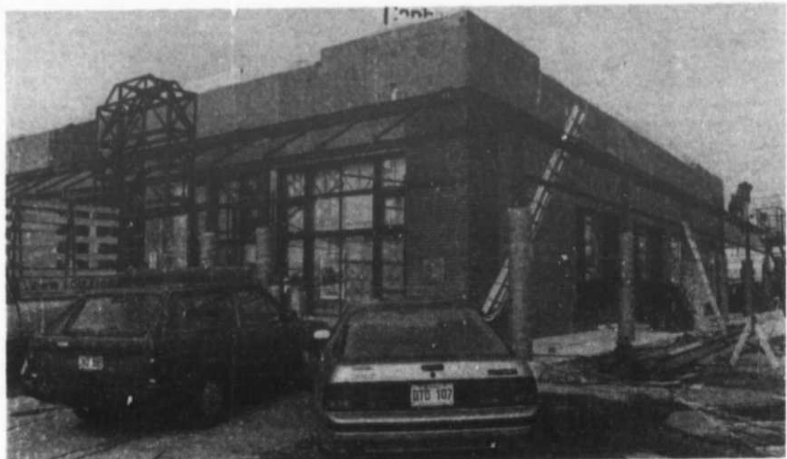
Les travaux de rénovation du centre commercial la Vallée-du-Richelieu devraient se terminer vers la fin avril.
