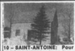
10 - SAINT-ANTOINE: Pour amateurs de la nature, 2 cac, foyer sans perte de chaleur, salon ouvert s/manger, face à eau + partie bord: À vous pour 89 500 $.
