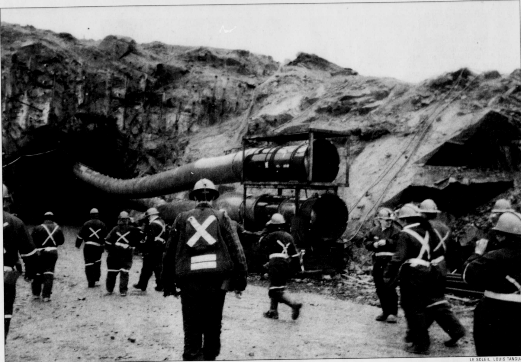
Dans cet environnement austère, le roc est aussi nu à l'extérieur qu'à l'intérieur de la rampe d'accès aux galeries souterraines de la mine, dont on voit à droite l'extrémité des conduits de ventilation.
