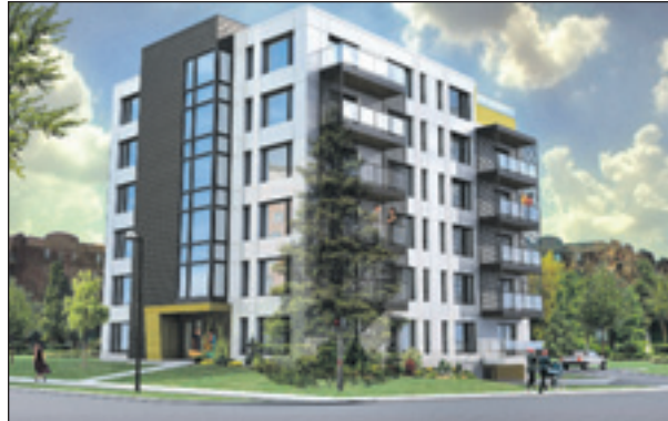
Le projet Alto condominiums, situé à l'angle de la rue Laudance et du chemin Sainte-Foy, comprendra 22 unités.
