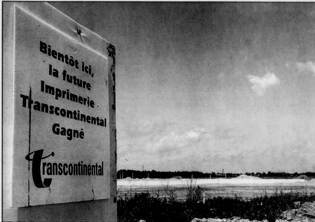
Les murs de la future imprimerie Transcontinental Gagné de Louiseville seront montés dans deux semaines.
