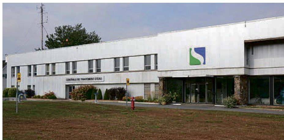
Des travaux ont été reportés à la centrale de traitement d'eau de Sorel-Tracy en raison de coûts trop élevés par rapport à l'estimation. (Photo : archives)
