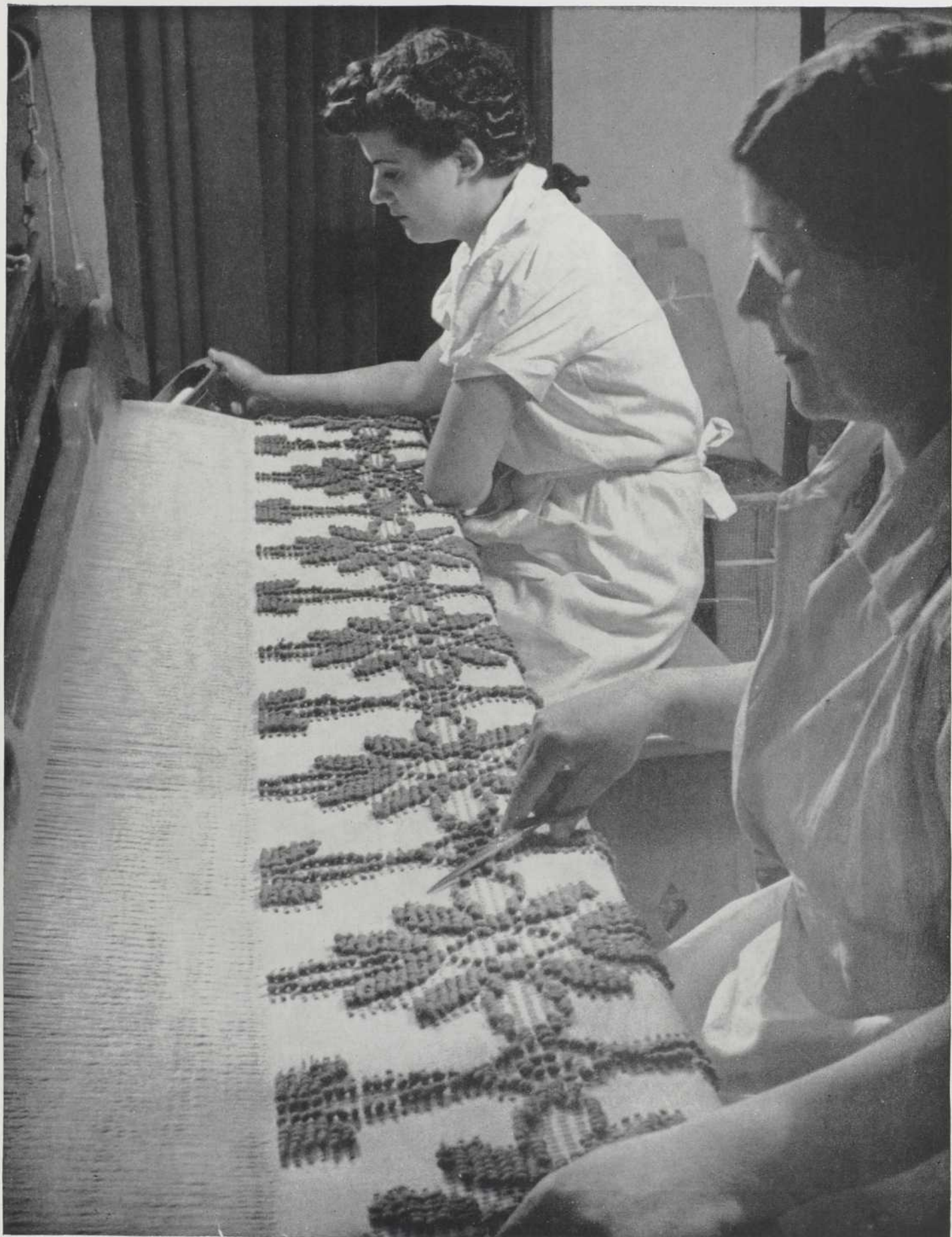
Tissage d'un couvrelit boutonné sur métier double largeur.
