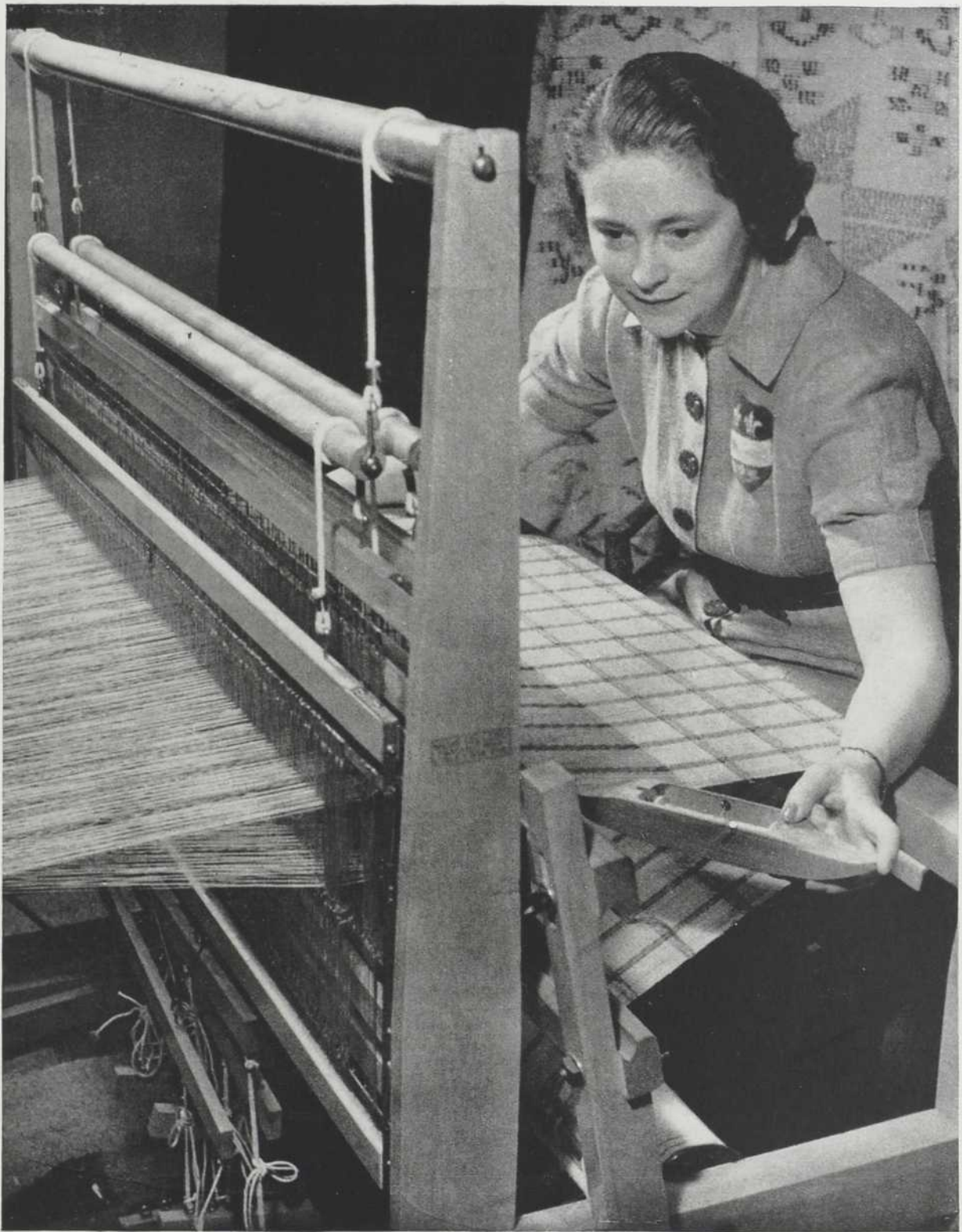
Le tissage sur métier à quatre lames.
