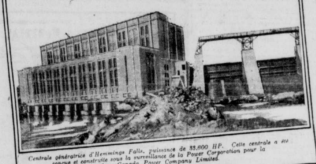
Centrale génératrice d'Hemmings Falls, puissance de 33,800 HP. Cette centrale a été conçue et construite sous la surveillance de la Power Corporation pour la Southern Canada Power Company Limited.
