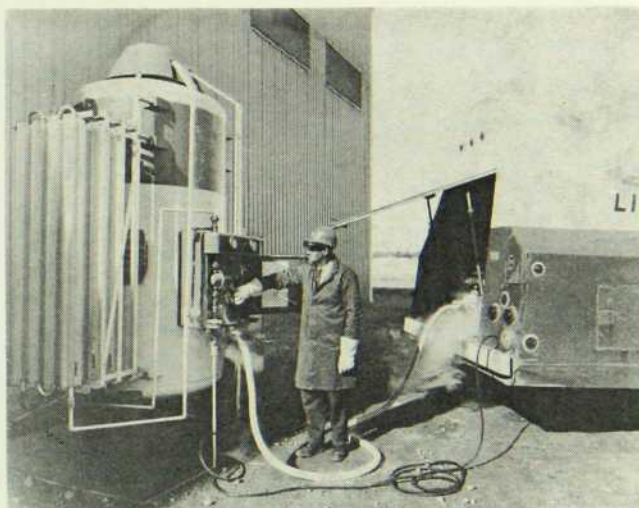
Remplissage d'un réservoir d'oxygène liquide à l'extérieur de l'usine d'un client.
