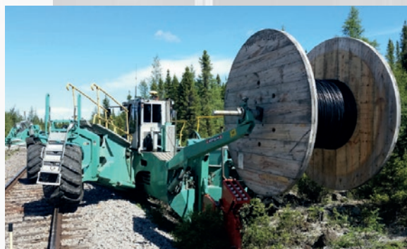
Photo : Installation d'un câble de fibre optique Crédit : Naskapi Imuun
