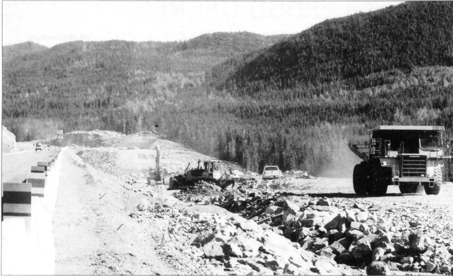
De nombreuses plaintes ont été adressées au ministère québécois des Transports relativement à l'utilisation des camions hors route par certains entrepreneurs, sur les plus grands chantiers de la province comme celui de la route 175 qui traverse la Réserve faunique des Laurentides. Ces véhicules énormes font jusqu'à 50 tonnes et ils peuvent contenir deux fois le chargement d'un camion 10 roues ordinaire.
