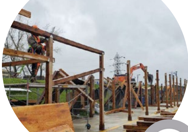
Station temporaire du REM Bois-Franc, pendant la déconstruction
