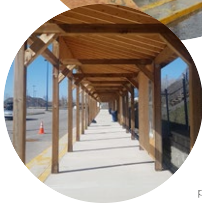
Station temporaire du REM Bois-Franc, avant la déconstruction
