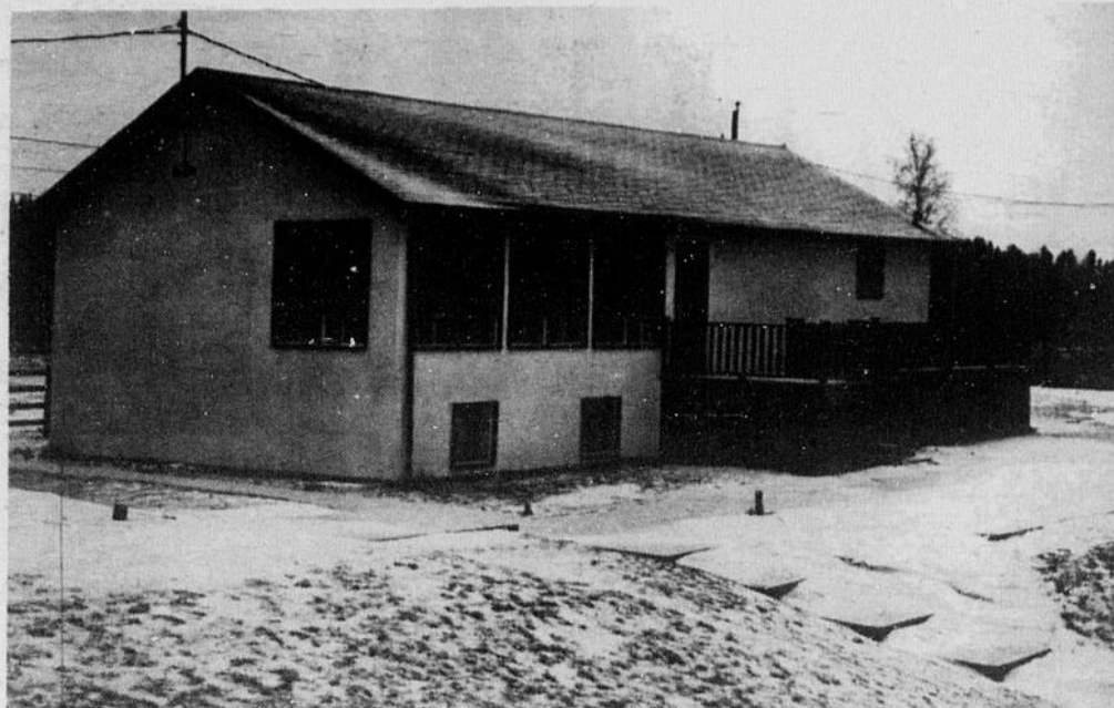
L'édifice principal de la Base Plein Air de St-Gédéon, au rez-chaussé on y trouve cuisine et cafétéria, au sous-sol ce sont les bureaux administratifs de même que les douches et toilettes. Cette année nous y retrouverons également une garderie d'enfants.
